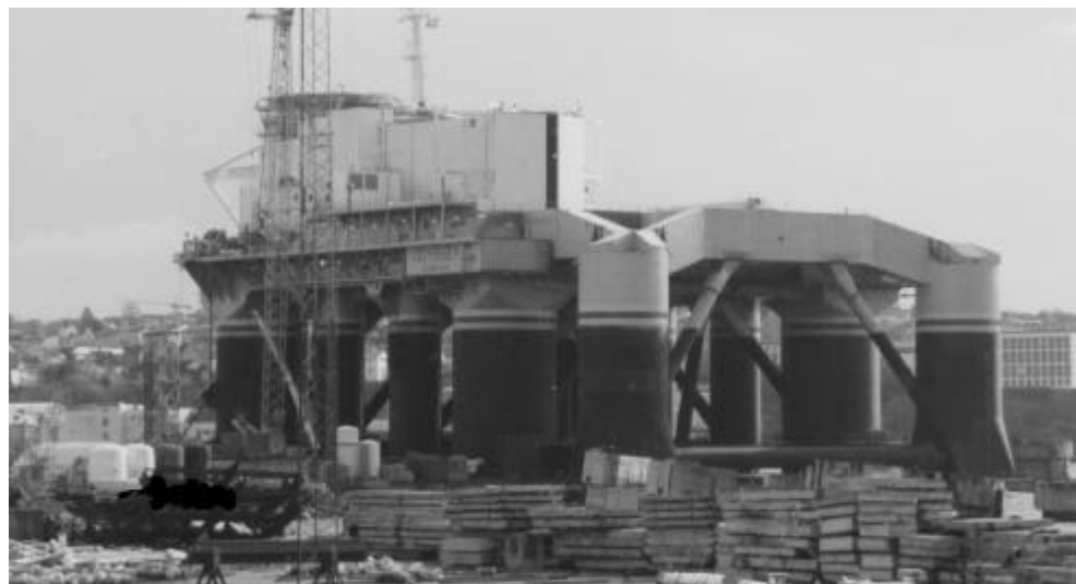
Weltgrößtes Recyclingprojekt: Umbau einer Ölplattform zur Raketenabschubrampe für Satelliten
